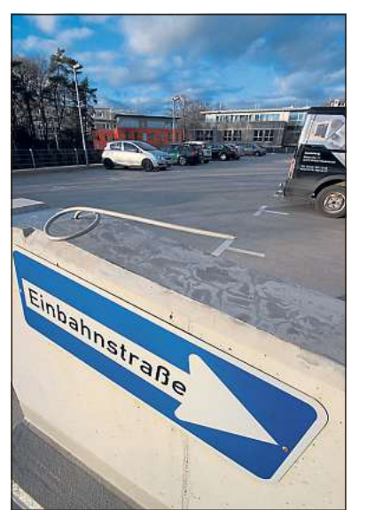
Der Bauantrag für die Aufstockung des Parkdecks ist gestellt, die Baugenehmigung steht noch aus. Bilder: Dinkels
